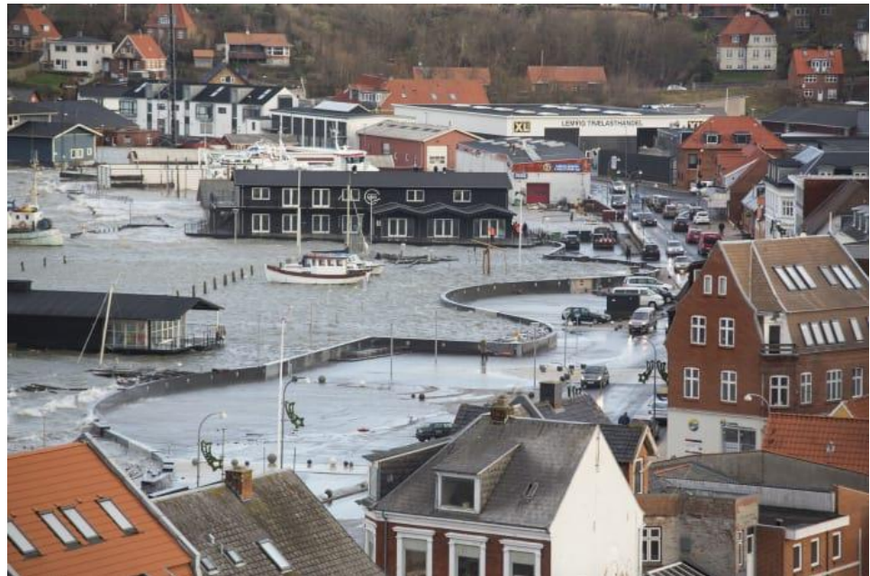
Illustration 5.1. Centrale del af havnen under stormen Bodil, hvor højvandet toppede 23 cm fra kanten på den 350 meter lange højvandsmur (Foto: Mads Krabbe)
