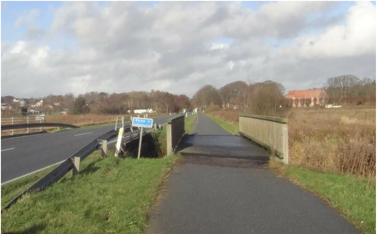
Figur 17: Sætninger af dæmning ved overførsel af cykelsti ved Thorsagervej, her set mod nord. Dæmningen er ca. 1,2 m over omgivende terræn. Der er sket en sætning på ca. 15 cm ved cykelstien. Der er ikke sporet sætninger af betydning i vejen. Cykelstien blev etableret omkring 2006. Thorsagervej var etableret i 1944.
