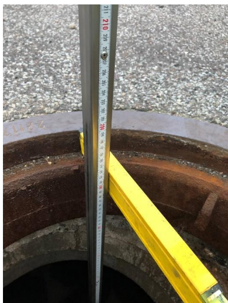
Figur 5.5. Det anvendte princip for nedstik. Waterpas tilpasset tykkelsen på brøndlåget. Nedstikket måles fra overkant af waterpas til bundløb i brøndmidte - to gange aflæsning med forskudt skala på 1,150 meter. Aflæsninger føres direkte ind i programmet, der beregner og sammenligner de to højdeforskelle. Ved en difference på 5 mm eller derover måles der på ny. I dræn- og regnvandsbrønde er der målt til det nederste til- eller afløbsrør.
