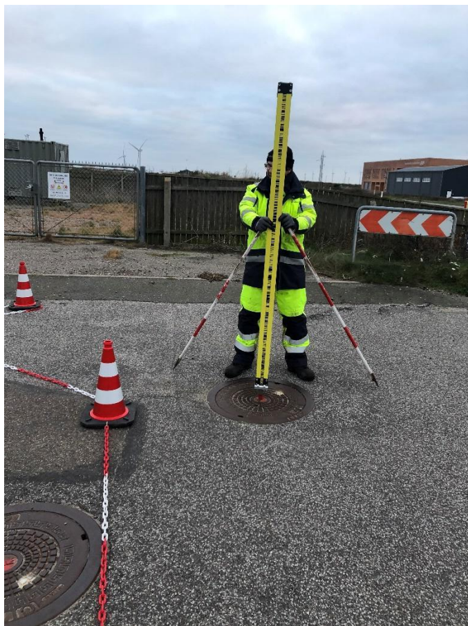
Figur 5.3. Brøndmålingen udført med geometrisk nivellement og Invar-stadier, støttestokke og adapter, der sikrer, at dækslerne kan anvendes som overgangspunkter i nivellementet.
