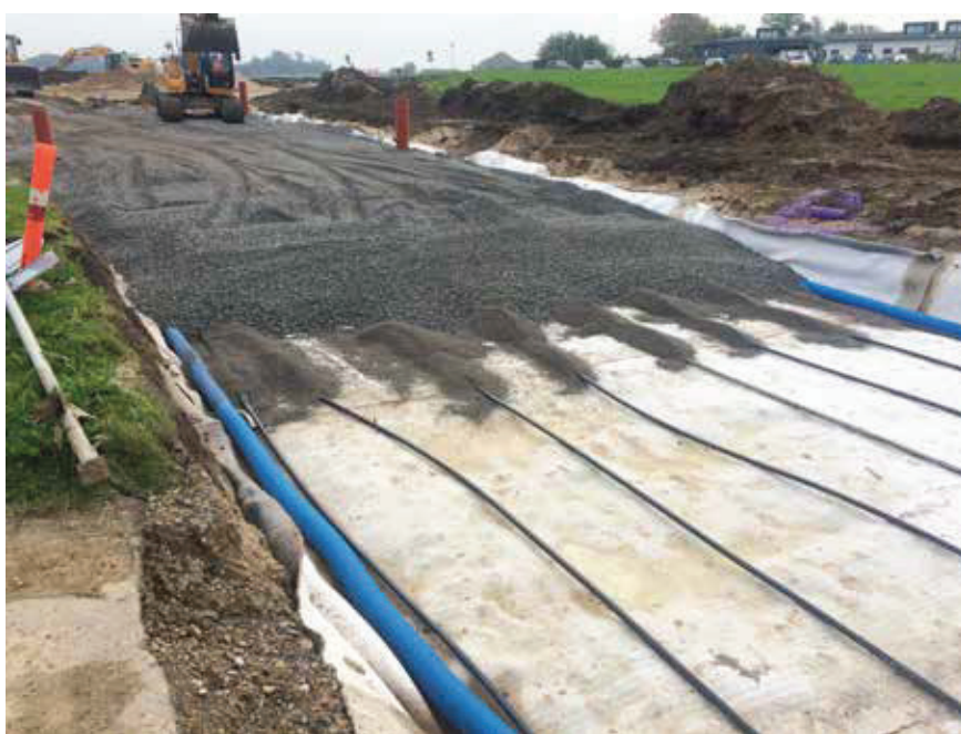
Billede af vejkassen. Bentonitmåtten ses med hvidt, de nedre jordvarmeslanger ses nederst i billedet over bentonitmåtten, mens dræningssystemet ses med blå. Foto: Theis Raaschou Andersen
