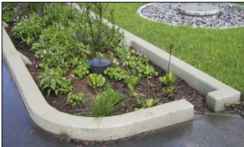
Figur 2. Regnbed etableret af Byggros. Foto: Byggros, 2022.
