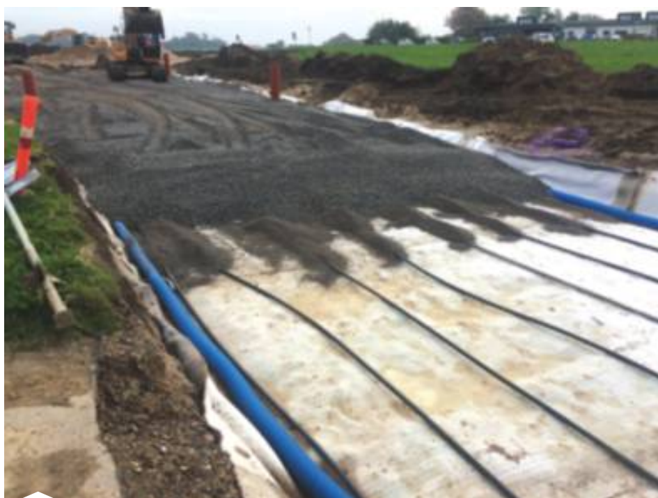
Klimavejen i Hedensted blev taget i brug i 2018 og er et af de mere håndfaste projekter fra klimatilpasningspartnerskabet C2C CC. Vejens permeable belægning er designet til at håndtere store mængder regnvand. Samtidigt er der nedlagt jordvarmeslanger i vejen, der udvinder varme fra regnvandet til opvarmning af den nærliggende børnehave Lille Dalby. Foto: Theis Raaschou, VIA University College.
