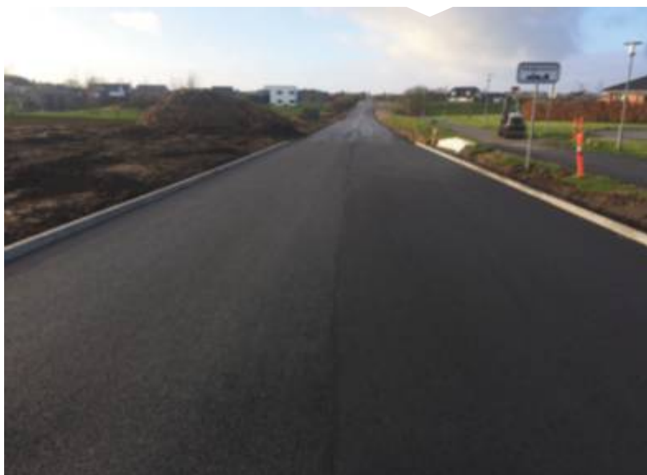
Klimavejen i Hedensted blev taget i brug i 2018 og er et af de mere håndfaste projekter fra klimatilpasningspartnerskabet C2C CC. Vejens permeable belægning er designet til at håndtere store mængder regnvand. Samtidigt er der nedlagt jordvarmeslanger i vejen, der udvinder varme fra regnvandet til opvarmning af den nærliggende børnehave Lille Dalby. Foto: Theis Raaschou, VIA University College.
