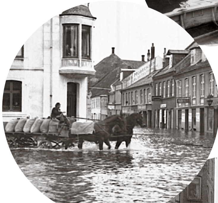
Oversvømmelse ved Frederiksplads og Carolinegade (nuv. Østervold) 1921. Randers Stadsarkiv
