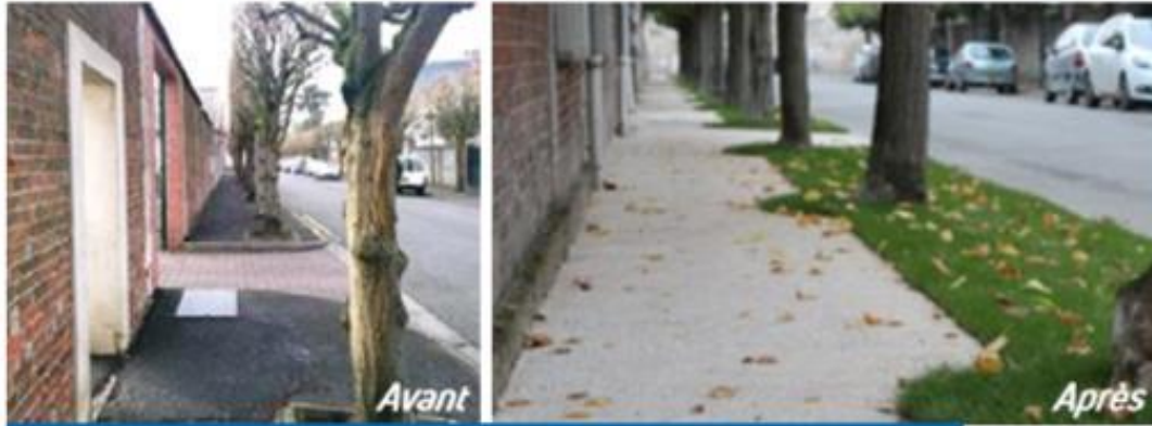
Rue du Général Leclerc avant et après réfection
